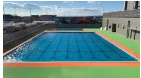
プールの様子 すでに水が張ってありました
