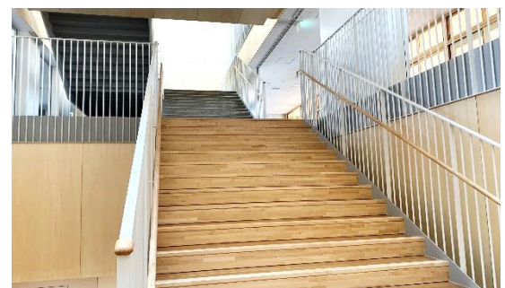
階段の幅はこれまでの倍くらいありゆったり開放的です
