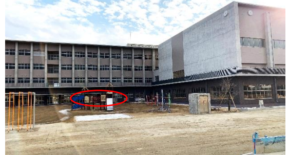
新校舎北側から ※赤〇で囲んだところが全学年昇降口
