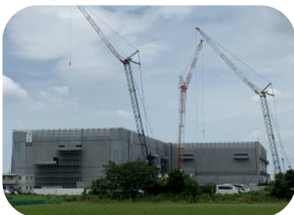
◇クレーン注目、随分な高さです
